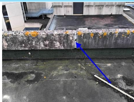
Matériaux : ZPSO-016 Prélèvement : P022 Description : Joint de dilatation Localisation : Toiture terrasse - CB T024 Résultat : Absence d'amiante
