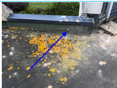
Matériaux : ZPSO-005 Prélèvement : P011 Description : Relevé : revêtement bitumineux (bandes, lés...) Localisation : Toiture terrasse - CB T024 Résultat : Absence d'amiante
