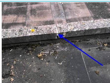
Matériaux : ZPSO-029 Prélèvement : P046 Description : Joint de dilatation Localisation : Toiture terrasse - CB T015 Résultat : Absence d'amiante
