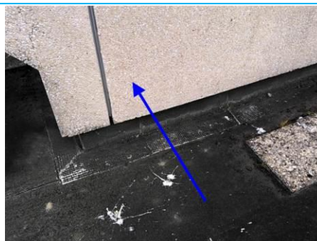
Matériaux : ZPSO-031 Prélèvement : P048 Description : Enduit + béton Localisation : Toiture terrasse - CB T015 Résultat : Absence d'amiante
