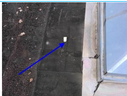
Matériaux : ZPSO-025 Prélèvement : P036 Description : Partie plane : revêtement bitumineux réparation Localisation : Toiture terrasse - CB T019 Résultat : Absence d'amiante
