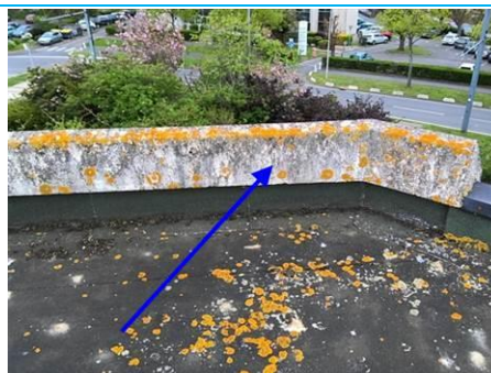
Matériaux : ZPSO-017 Prélèvement : P024 Description : Enduit + béton Localisation : Toiture terrasse - CB T024 Résultat : Absence d'amiante
