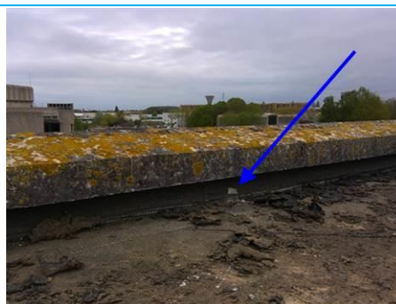
Matériaux : ZPSO-014 Prélèvement : P020 Description : Relevé : revêtement bitumineux (bandes, lés...) Localisation : Toiture terrasse - CB T024 Résultat : Absence d'amiante
