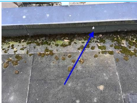
Matériaux : ZPSO-028 Prélèvement : P043 Description : Relevé : Béton Localisation : Toiture terrasse - CB T019 Résultat : Absence d'amiante
