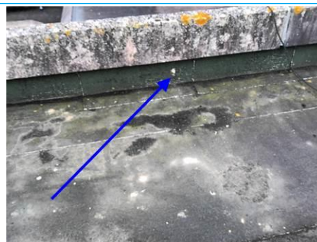
Matériaux : ZPSO-006 Prélèvement : P010 Description : Relevé : Béton Localisation : Toiture terrasse - CB T024 Résultat : Absence d'amiante
