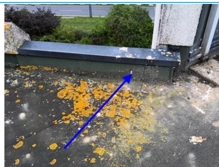
Matériaux : ZPSO-006 Prélèvement : P012 Description : Relevé : Béton Localisation : Toiture terrasse - CB T024 Résultat : Absence d'amiante
