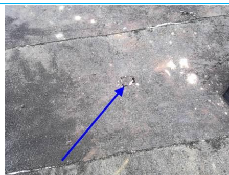
Matériaux : ZPSO-004 Prélèvement : P008 Description : Partie plane : Béton Localisation : Toiture terrasse - CB T024 Résultat : Absence d'amiante
