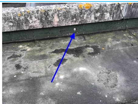
Matériaux : ZPSO-005 Prélèvement : P009 Description : Relevé : revêtement bitumineux (bandes, lés...) Localisation : Toiture terrasse - CB T024 Résultat : Absence d'amiante
