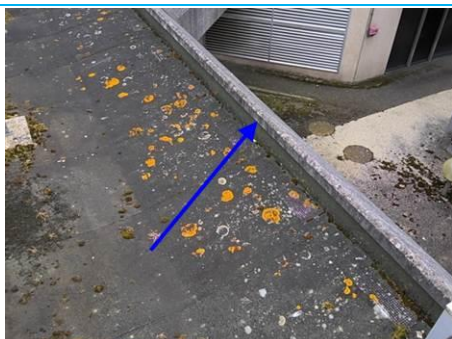
Matériaux : ZPSO-030 Prélèvement : P047 Description : Enduit + béton Localisation : Toiture terrasse - CB T008a Résultat : Absence d'amiante
